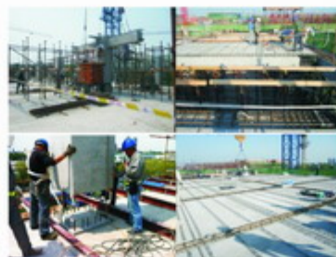
预制构件现场吊装
